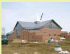
建設中の東口駅舎。あたたかみのあるレンガの壁面が周辺の景観になじみます。
