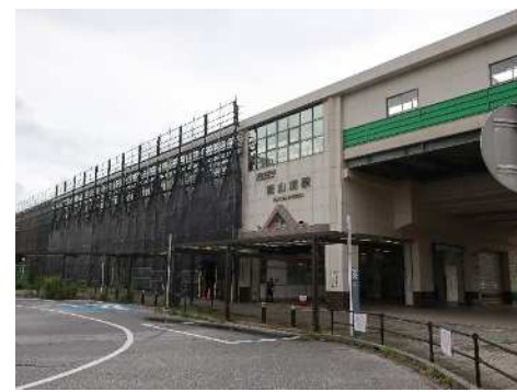
▲飯山満駅の駅外壁修繕工事
