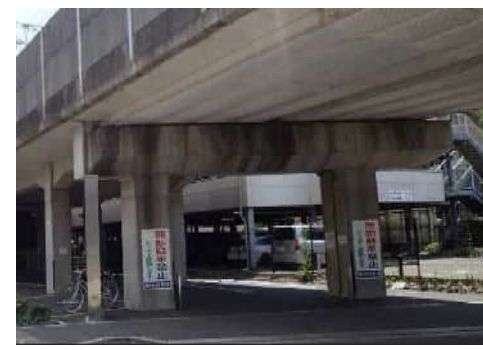
▲高架橋柱の耐震補強工事前後
