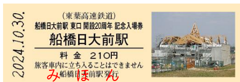
(東口駅舎建設中)
